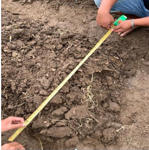
Gambar pengukuran lebar bedengan
