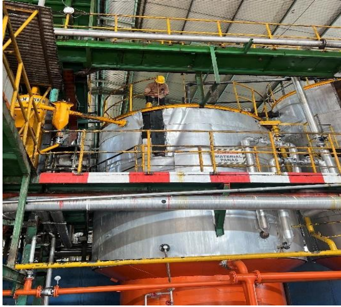
Gambar 4.3 Pemeriksaan pada Crude Oil Tank
