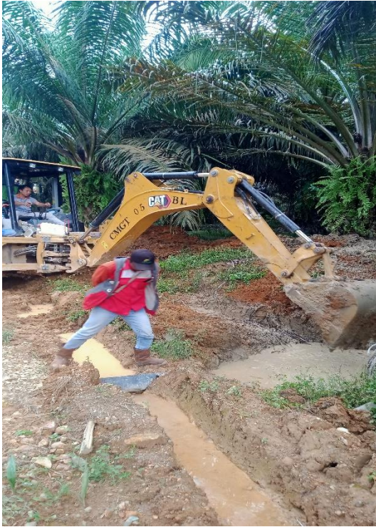
Gambar Pembuatan Rorak
