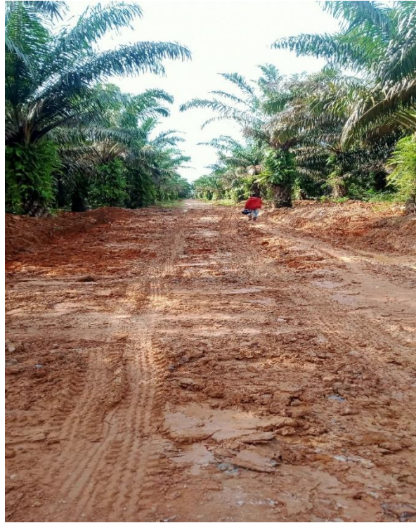
Gambar Jalan Rusak
