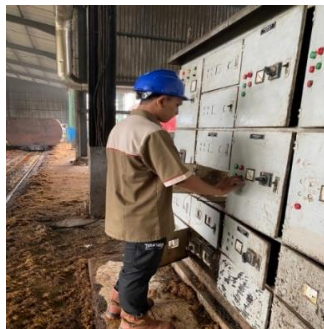
Gambar 4. 2Menyalakan arus listrik pada panel
