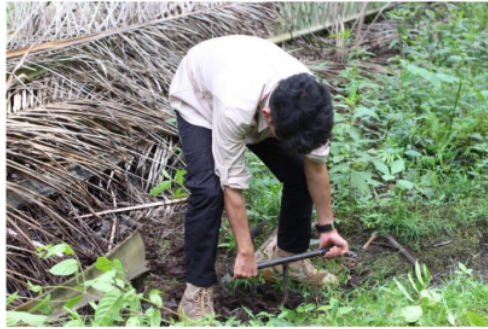
Gambar 1.7 Penggalian lubang piezometer
