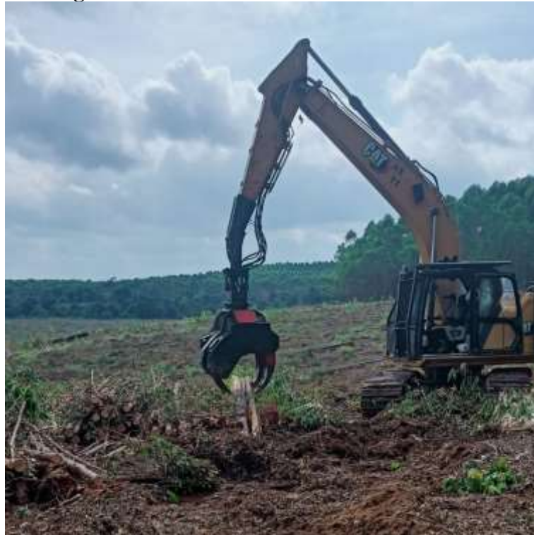
Lampiran 1. Excavator Caterpillar AS 11 20 ton attachment Grapple saw sacto 630 dan tumpukan kayu sebelum di lakukan pembagian batang.
