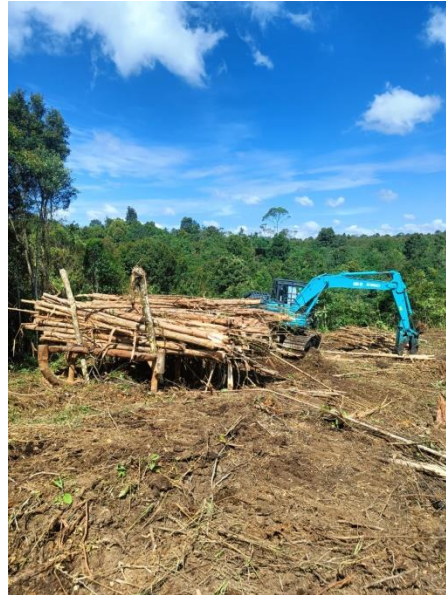
Gambar 4. Excavator ponton darat meng-ekstrak kayu ke Tpn
