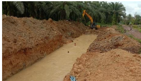
Gambar 4.5 Parit pengaman 4 x 4 x 3 m
