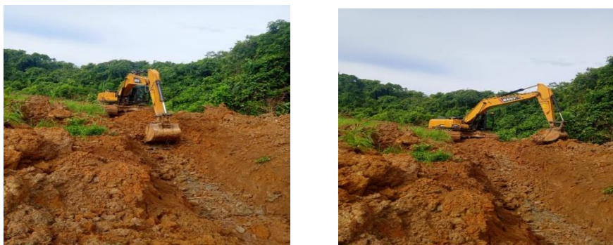
Gambar 5.5. Penggalian dan pembuatan parit pengamananan berbatas dengan pringgian
