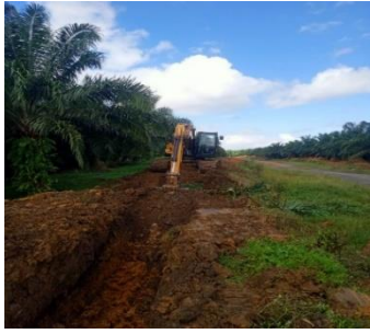
Gambar 5.6 Penggalian dan pembuatan parit pengamananan berbatas dengan pringan
