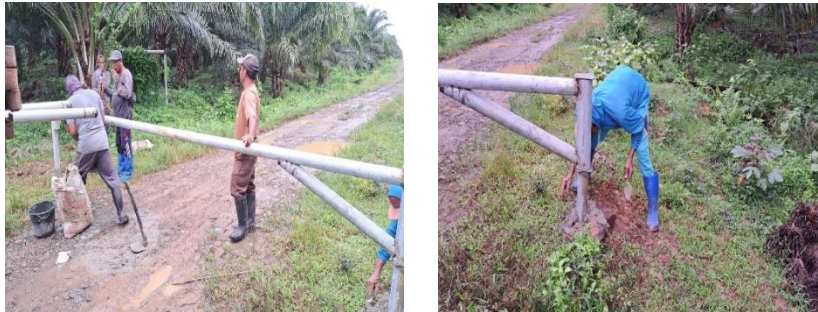
Gambar 5.3. Proses pemasangan dan pengecoran portal pada titik yang telah ditentukan
