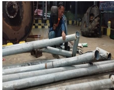
Gambar 1.2 .Proses perakitan sistem pengaman teknis (portal)
