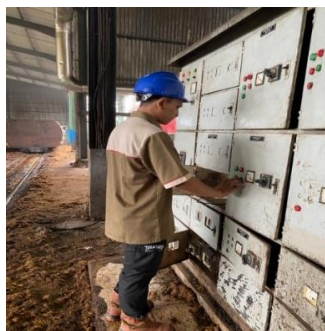
Gambar 4. 2 Menyalakan arus listrik pada panel
