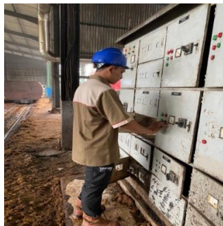
Gambar 4. 2Menyalakan arus listrik pada panel
