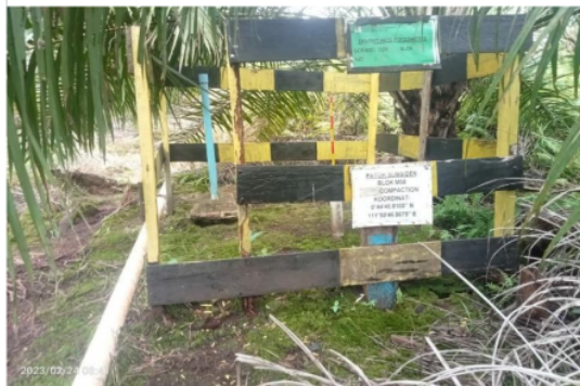
Gambar 4.9. Piezometer berdekapan patok subsiden
