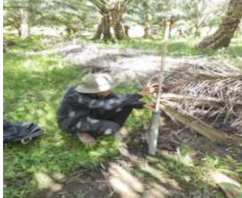
Lampiran 1.6 Pemasangan Piezometer
