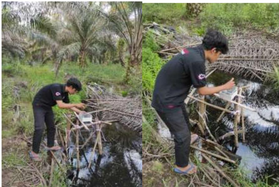
Gambar 1.6 pembuatan stand dan pemasangan alat Awlr
