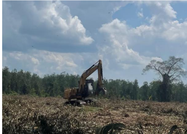
Proses Kegiatan Windrowing menggunakan Excavator Fix Grapple
