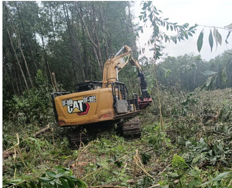
Proses Felling Menggunakan Directional Felling 13T
