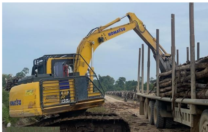
Proses Kegiatan Loading Menggunakan Excavator
