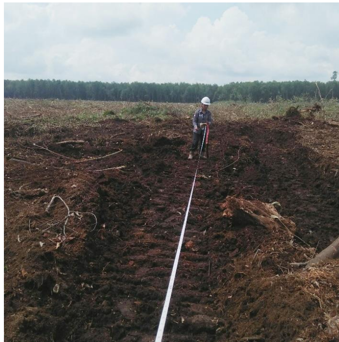
Lampiran 9 : Pengukuran dan Pemberian Patok Penanda Pada Jalur Sarad
