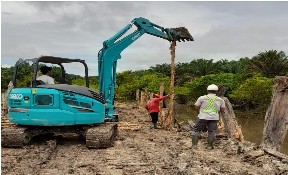
Gambar 7. Pemasangan cerucuk dengan menggunakan alat berat
