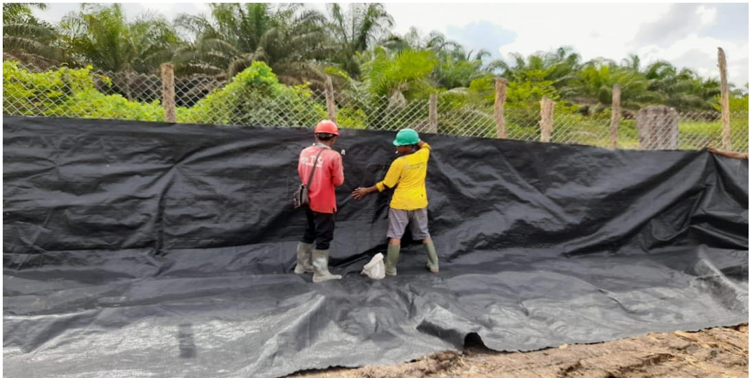
Gambar 9. Pemasangan geotek di tanggul
