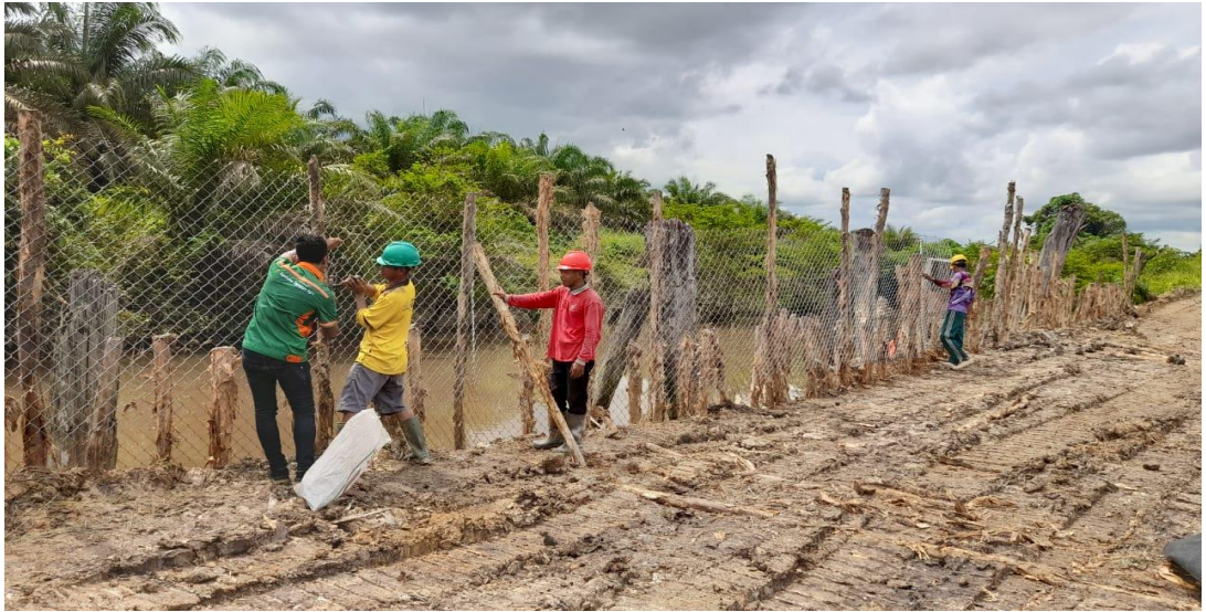
Gambar 8. Pemasangan cerucuk secara manual
