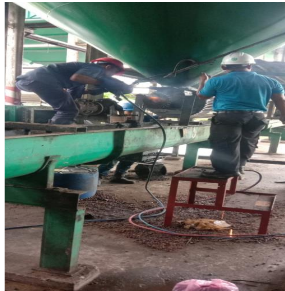
Foto pemasang kisi – kisi greeding drum
