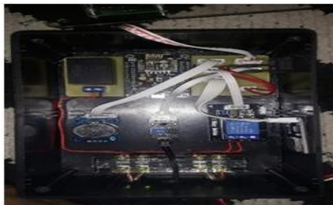
Gambar 4.4 Rangkaian Kontrol Irigasi Tampak Didalam Box Elektronik
