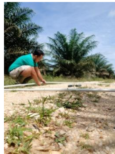
b) Penyambungan pipa paralon
