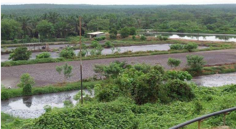
Gambar Instalasi Pengolahan Air Limbah (IPAL)
