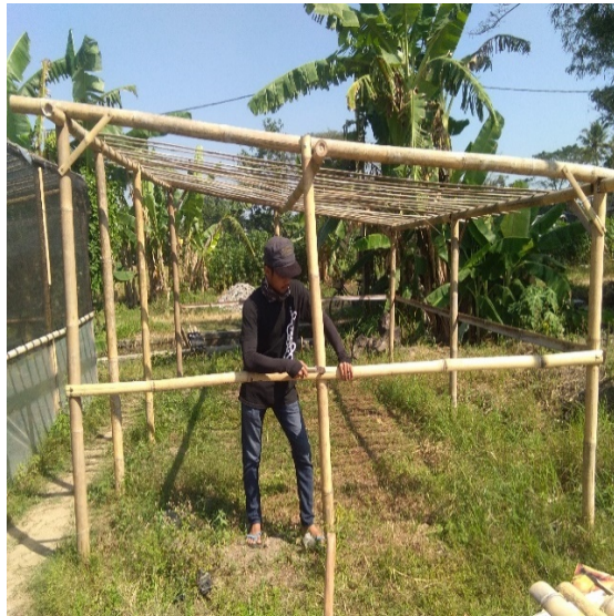
Gambar 9. Pembuatan bangunan penelitian.
