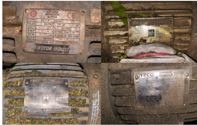
Gambar 43. Pengambilan data nameplate untuk perhitungan load factor
