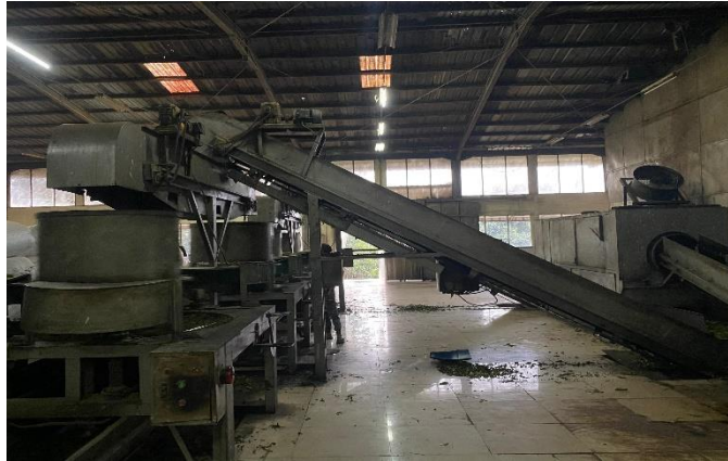
Gambar 38. Dokumentasi unit Cooling dan Open Top Roller (OTR) saat proses operasi
