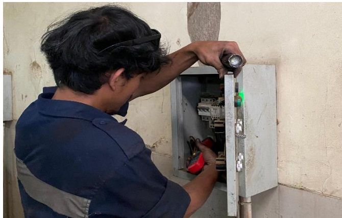
Gambar 33. Pengukuran arus dan tegangan menggunakan clamp meter
