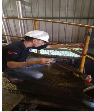
Pengukuran Level Minyak
