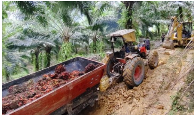
Gambar 1. 1 Jaringan Kondisi Jalan Perkebunan
